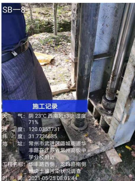
图4.1-1 本项目机械钻孔设备取样照片
